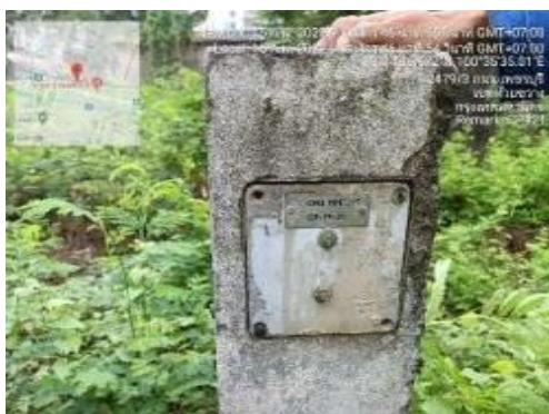
รูปที่ 2-13 (ต่อ) งานบำรุงรักษา Cathodic Protection
